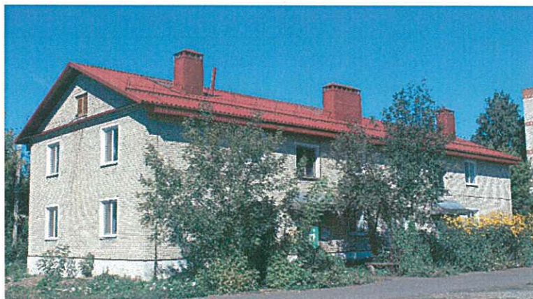
г. Асино, ул. Литатова, д. 23 после проведения капитального ремонта крыши
