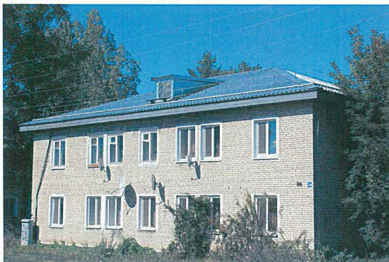
г. Асино, ул. им 370 Стрелковой дивизии, д. 34 после проведения капитального ремонта крыши
