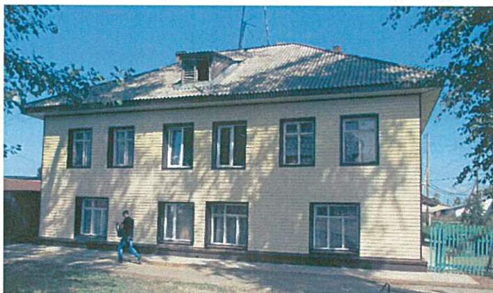
г. Колпашево, ул. Обская, д. 11 после проведения капитального ремонта фасада
